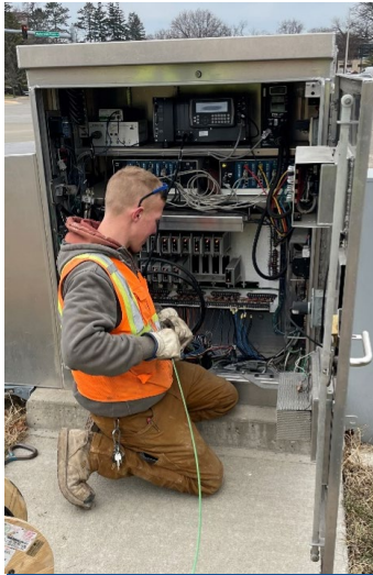
Mejoras en la señalización
