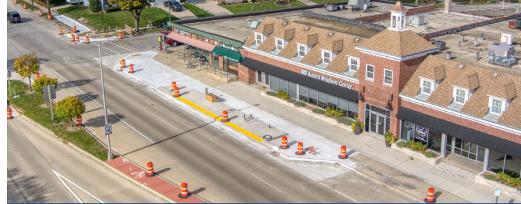
Construcción de bajo impacto
